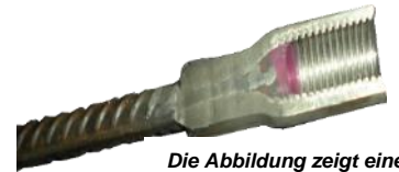
Die Abbildung zeigt einen aufgeschnittenen Transportanker mit dieser Versiegelung.
